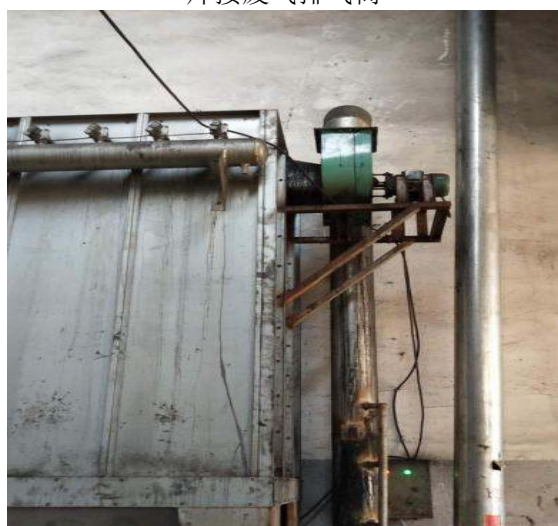
热风炉废气排气筒
