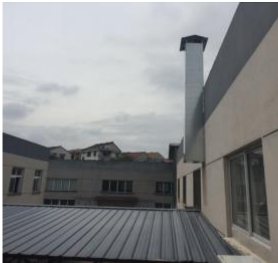
上油废气排气筒
