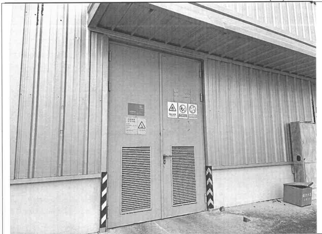
危废仓库外部
