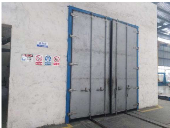
调漆、喷漆、晾干车间
