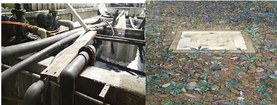
图 4-2 企业废水及排放口现场相关照片
