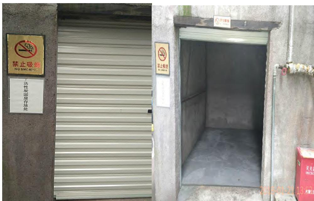
图 4-5 危废暂存库现场照片
