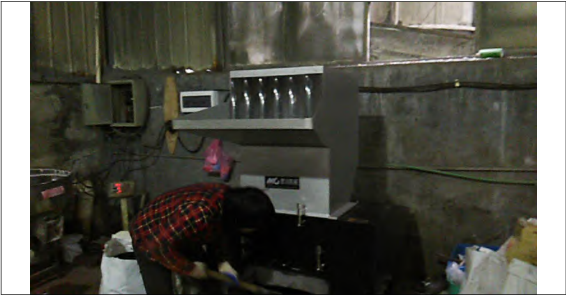
图 4-5 企业噪声治理现场相关照片
