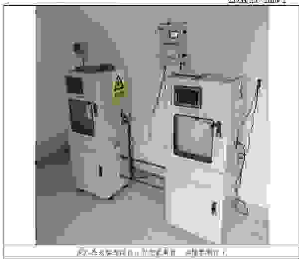
图 1-6 废水在线监测设备安装现场照片
