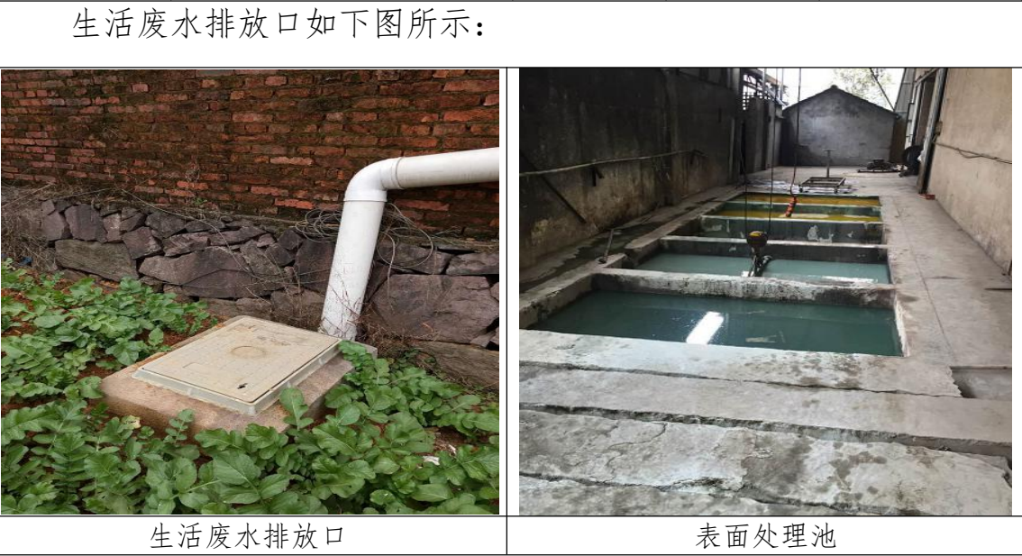
图 4-1 企业废水治理现场相关照片
