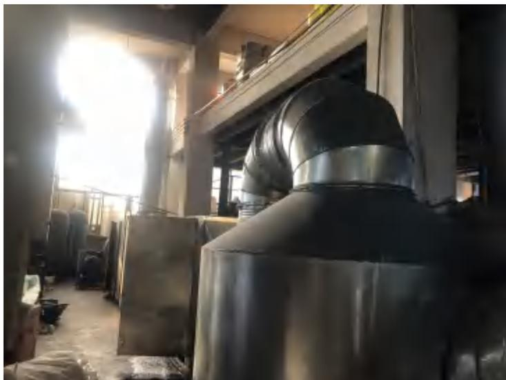
压铸、熔化、天然气废气处理设备
