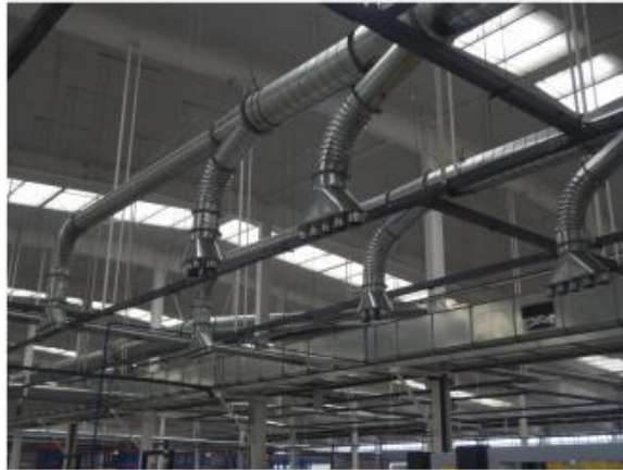
脉冲布袋式除尘器安装实例
