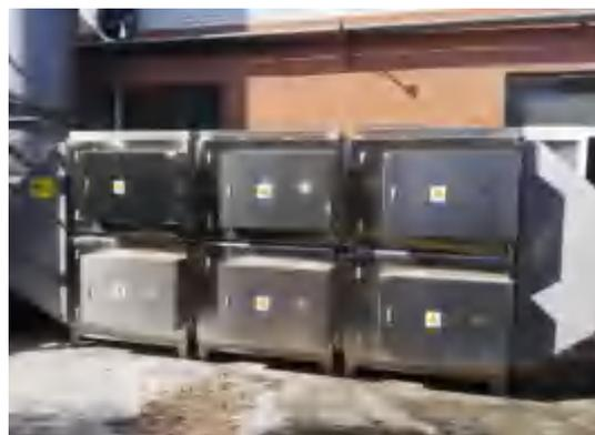
图 5-1 光催化废气净化器实物图
