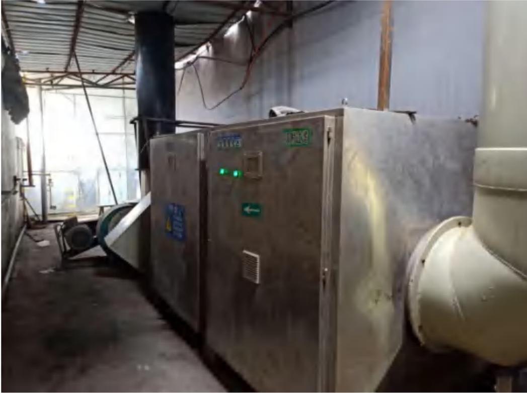
印刷上光废气处理设备
