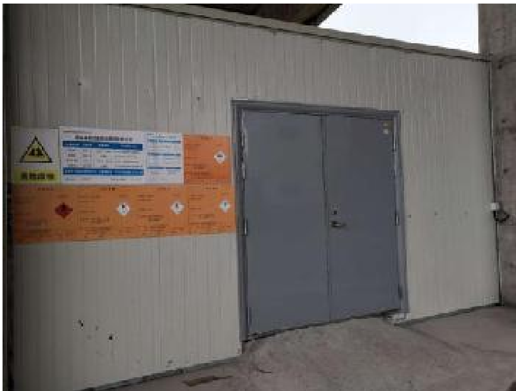
危险固废暂存场所
