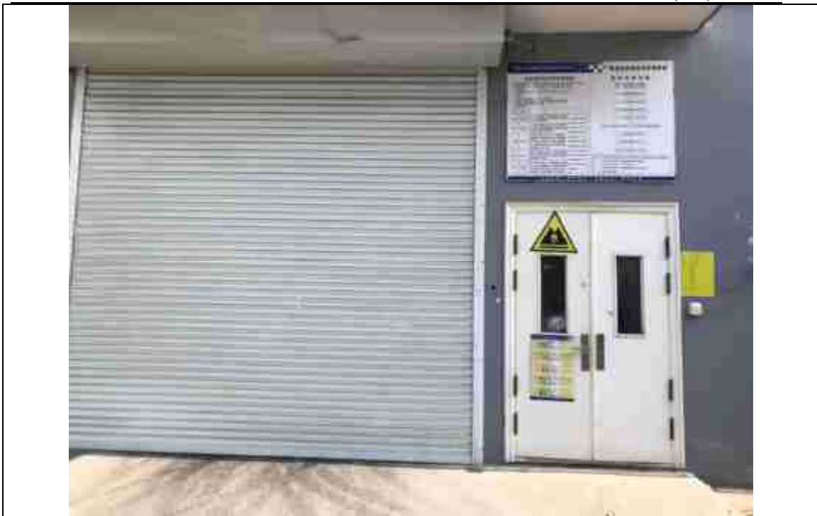
危废仓库外部照片
