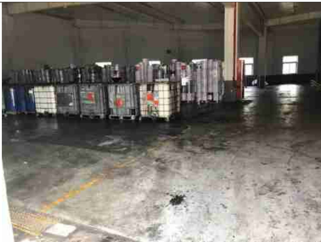
危废仓库内部
