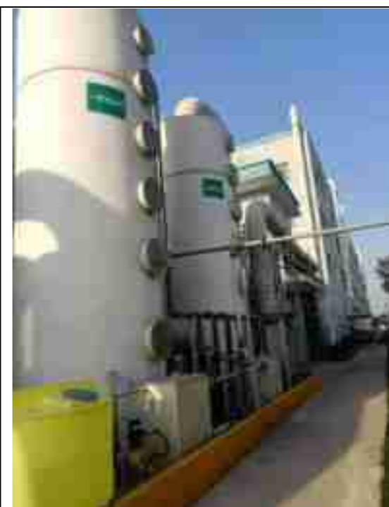
污水站废气处理设施（水喷淋+碱喷淋）
