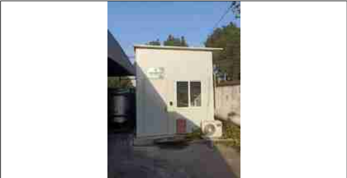
废水在线监控房照片
