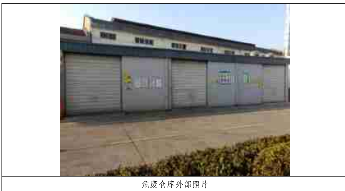
图 4-4 固废存放现场照片
