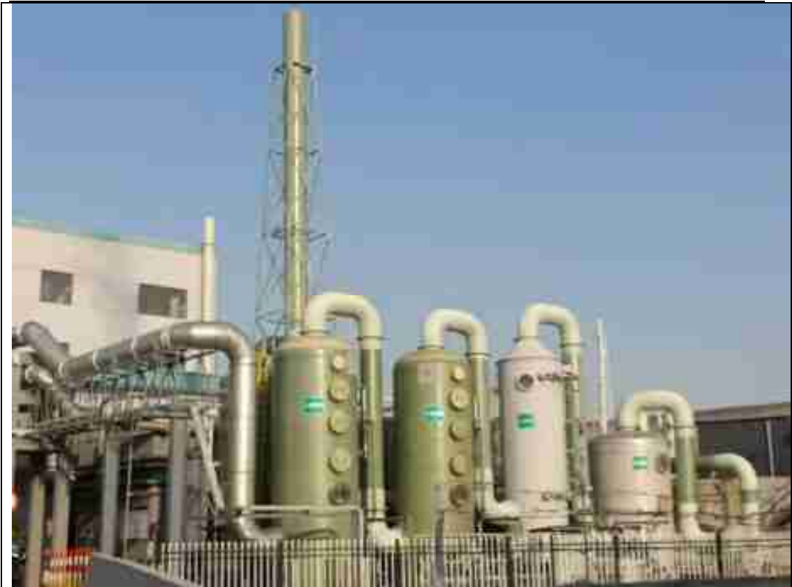
RTO 系统前处理（三级水喷淋+除雾器）
